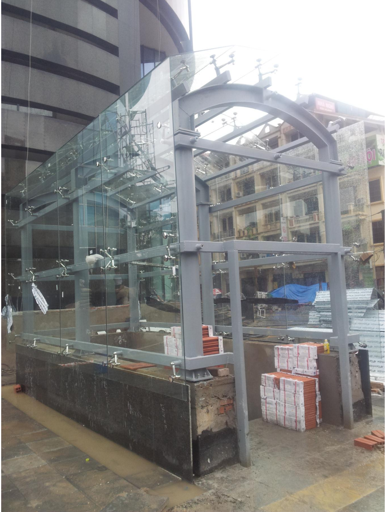
Dự án TTTM Trung Hòa, Cầu Giấy – Hà Nội
